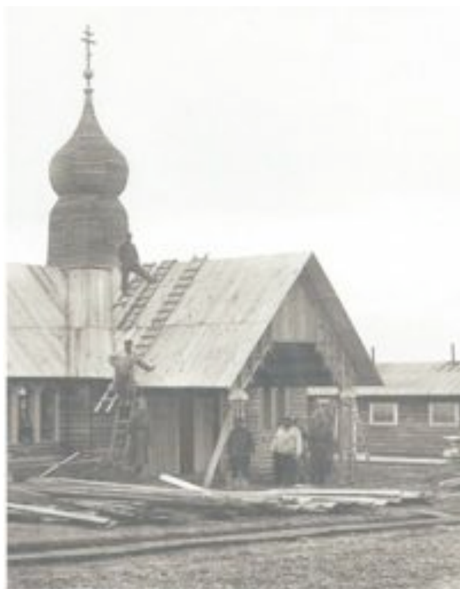
Construction d'une chapelle orthodoxe au camp de Mailly
